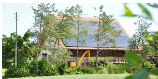
Eine Solaranlage auf dem Dach der Landwirtschaft «Sonnenhof». BILD PETER OBERHOLZER
