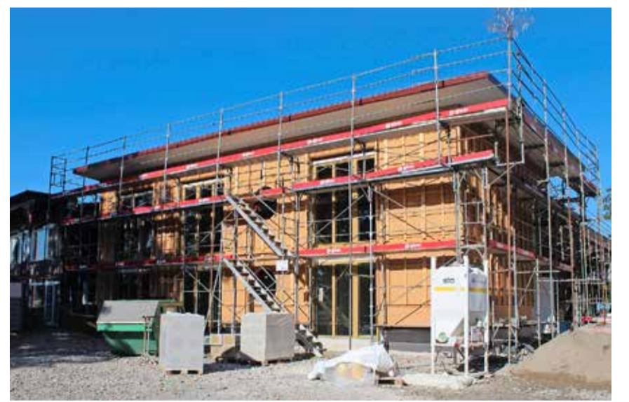
Die Aussenhülle des Erweiterungsbaus am Bachwiesen steht bereits. BILD ZVG
