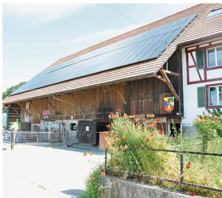
Solaranlage auf dem St. Annahof in Oberstammheim.
