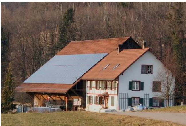
EINE VON ÜBER 100 Innert weniger als drei Jahren wurden im Zürcher Weinland dank der ProWeinland Aktion „100 Solardächer jetzt“ 109 Anlagen installiert ... und die Nachfrage hält an. (Foto JÖ)
